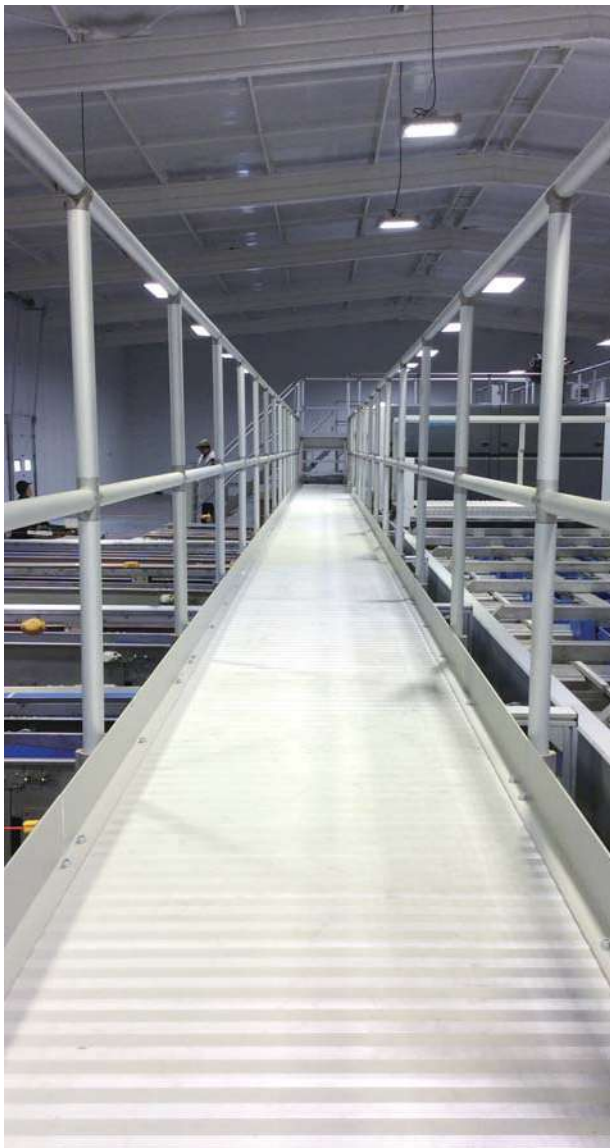
Bridge for Sorting Machine 分拣设备过线梯
