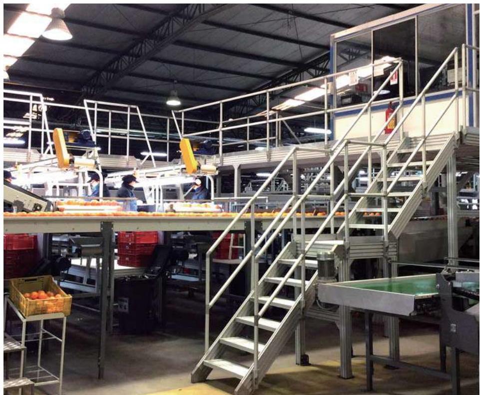
Bridge for Sorting Machine 分拣设备过线梯
